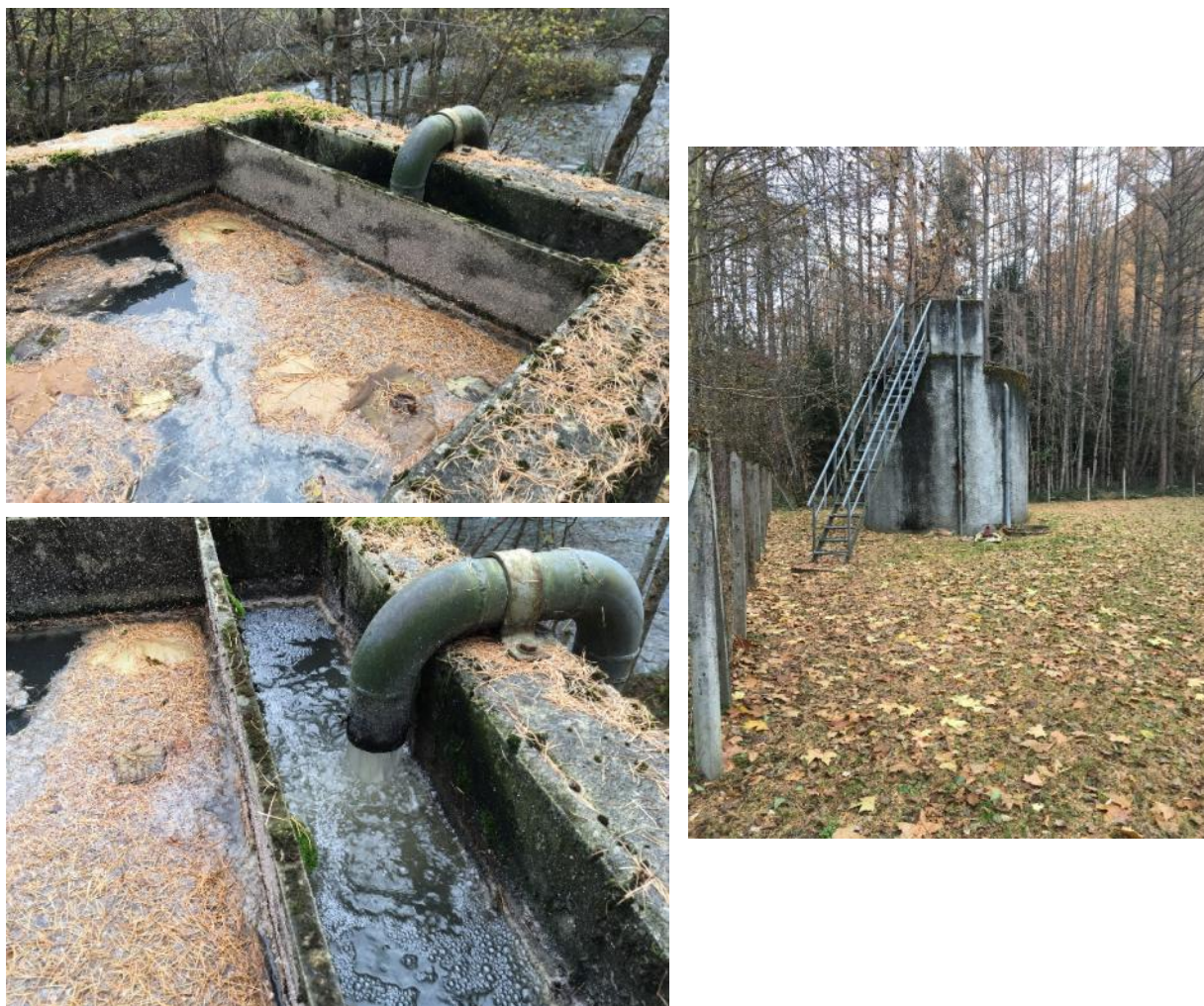
Figure 47 - Décanteur-digester de la STEP d'Orgeix
