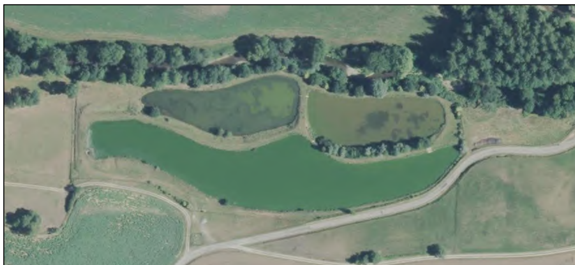
Figure 11 : Vue aérienne de la station d'épuration
