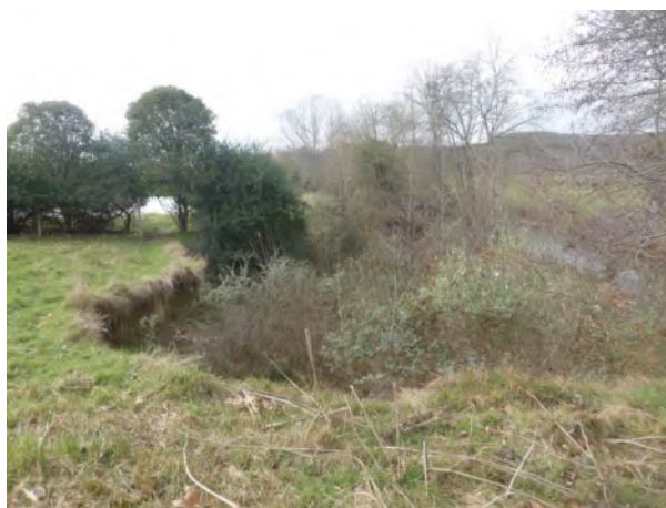
Forte érosion de la parcelle 10 en aval de la STEP
