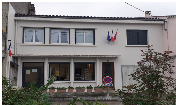
Mairie de SAINT QUENTIN LA TOUR
