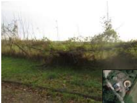
Clôture couchée (étoile rouge emplacement)
