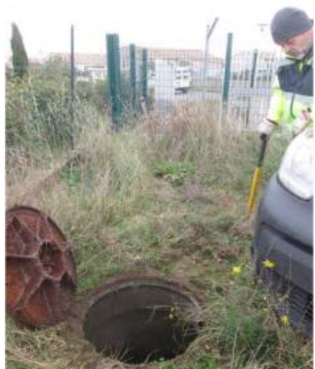
Regard d'arrivée des relèvements
