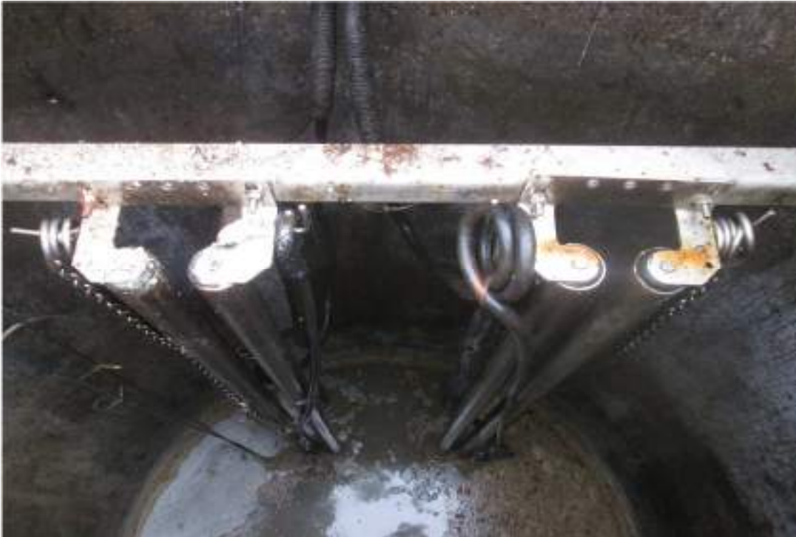
Accès à la bâche humide
