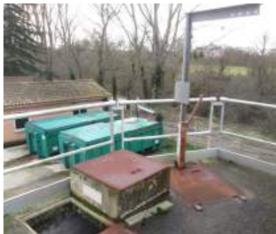
Trappes d'accès à l'intérieur du silo
