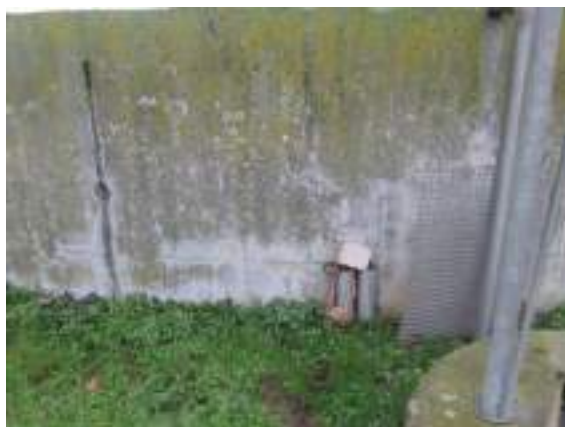
Boite de dérivation de la pompe et des poires
