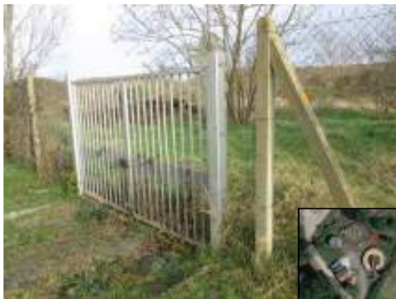
Clôture couchée (étoile rouge emplacement)
