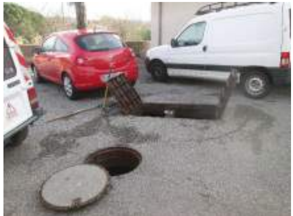
PR Vieux du Pont
