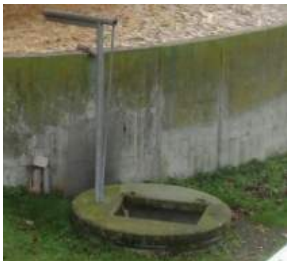
Poste toutes eaux
