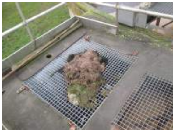
Trappes d'accès au poste de recirculation/extraction
