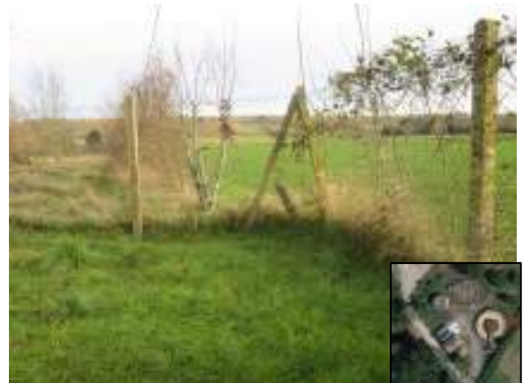
Clôture couchée (étoile rouge emplacement)
