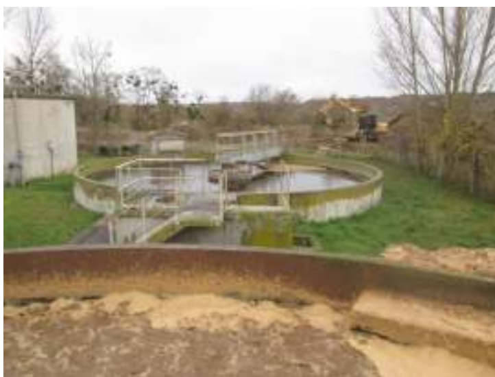
Vue des bassins (tampon et ultrafiltration)
