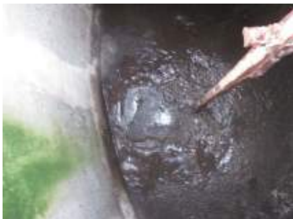
Intérieur du silo – barre de guidage de l'agitateur
