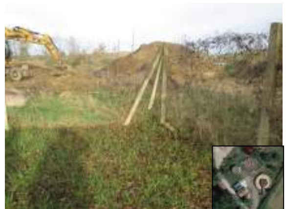
Clôture couchée (étoile rouge emplacement)
